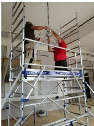
INSTALLATION DU LUSTRE
